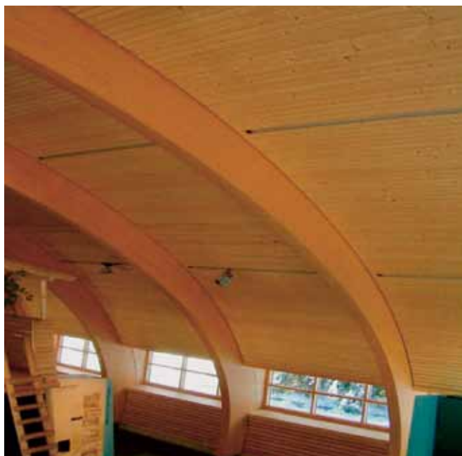
Slika 1. Sportska hala sa krovnim nosačima od LLD-a (foto: Glavonjić B. 2013.)
